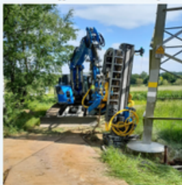
Abb. 2-3, Bohrbagger am Mast 8 beim BV Eiberg-Obladen, Fotograf. Andreas Richter.
