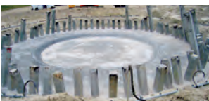
9. Kreisfundament nach Rammung und Aushub
