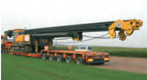
1. Anlieferung des Rammgerätes
