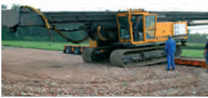
2. Entladung des Rammgerätes
