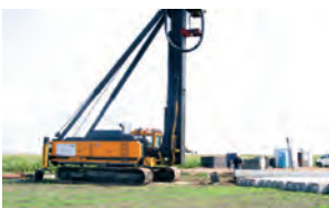
8. Aufnehmen eines weiteren Pfahles
