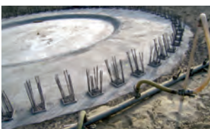
10. Kreisfundament nach den Kapparbeiten
