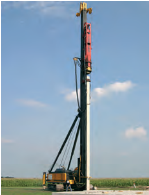
6. Hochziehen eines Pfahles
